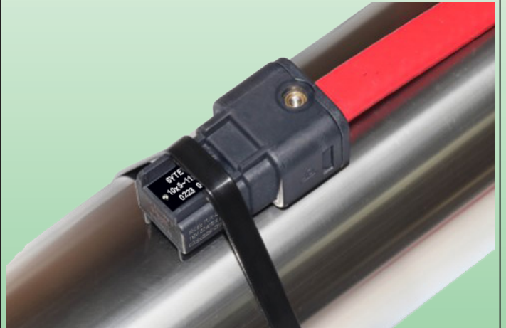
电缆插入拧紧并安装在管道上
